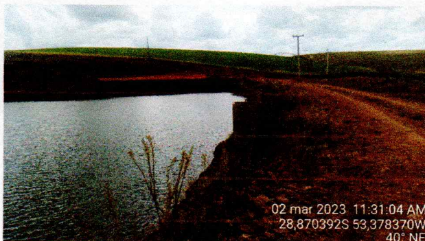
Imagem 07- Barragem a ser regularizada.
