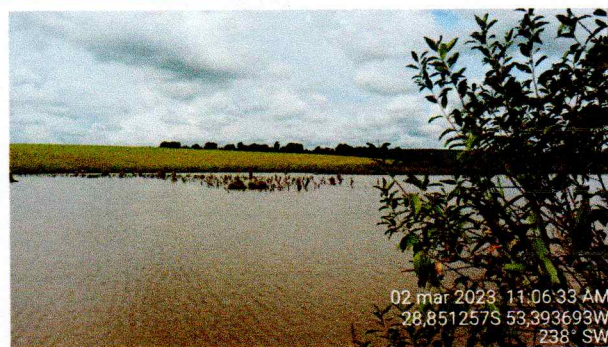
Imagem 05 – Barragem já licenciada anteriormente pela FEPAM.
