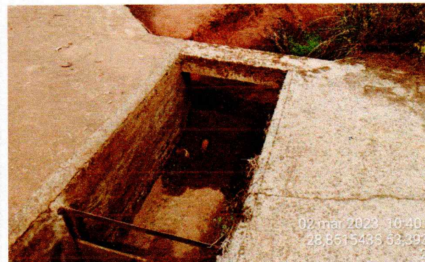
Imagem 06 –Vertedor Sistema de segurança da barragem
